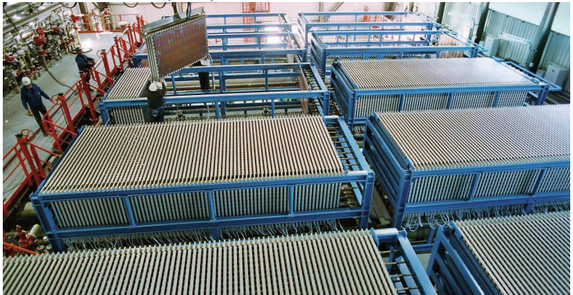
Montage der Module eines bipolaren Uhde BM 2.7 Elektrolysiers
